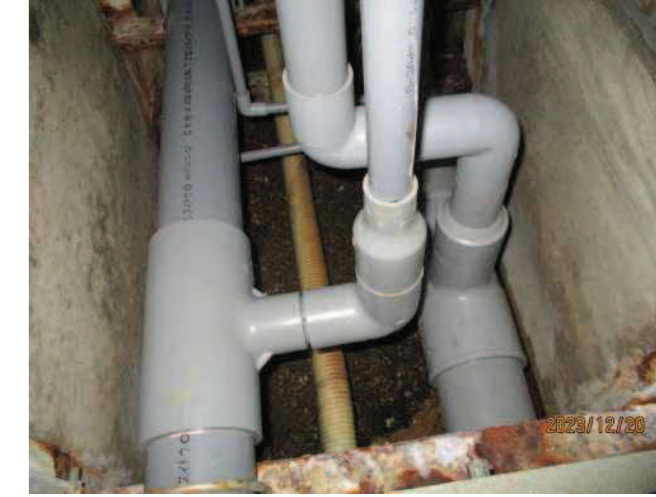
No-9 IMG4879 ビット内 壁、底クラック無し
