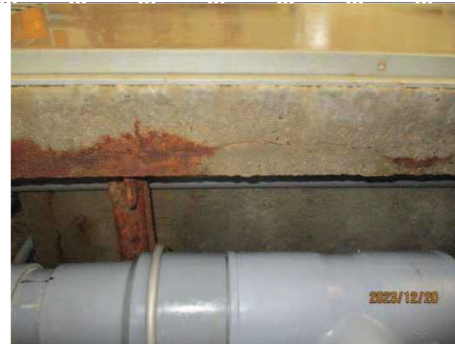
No-6 IMG4872 並行ビット 床断面にクラック
