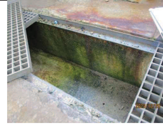
No-8 IMG4876 ビット内 壁、底クラック無し
