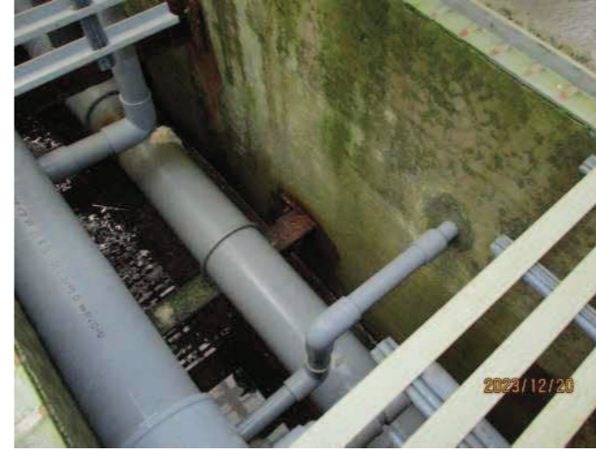
No-4 IMG4870 ビット内 壁、底クラック無し
