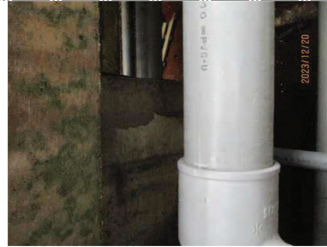
No-5 IMG4871 並行ビット内 床支持壁にクラック
