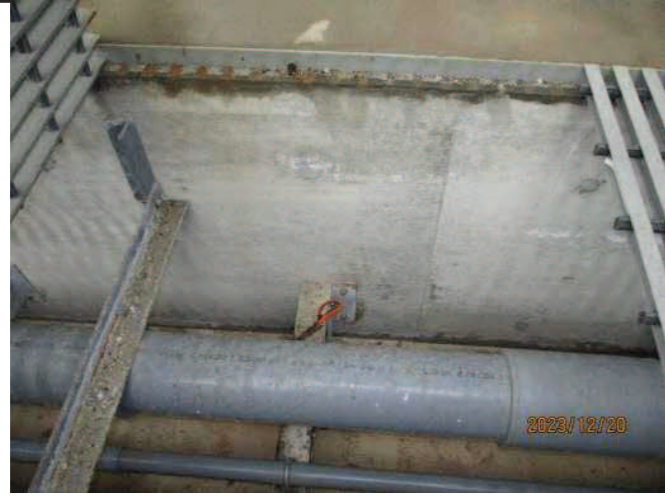
No-1 IMG4864 ビット内 壁、底クラック無し
