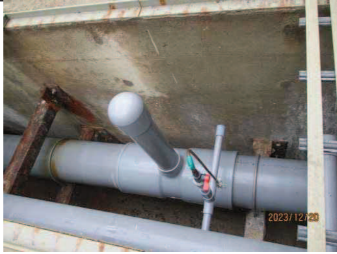
No-2 IMG4867 ビット内 壁、底クラック無し
