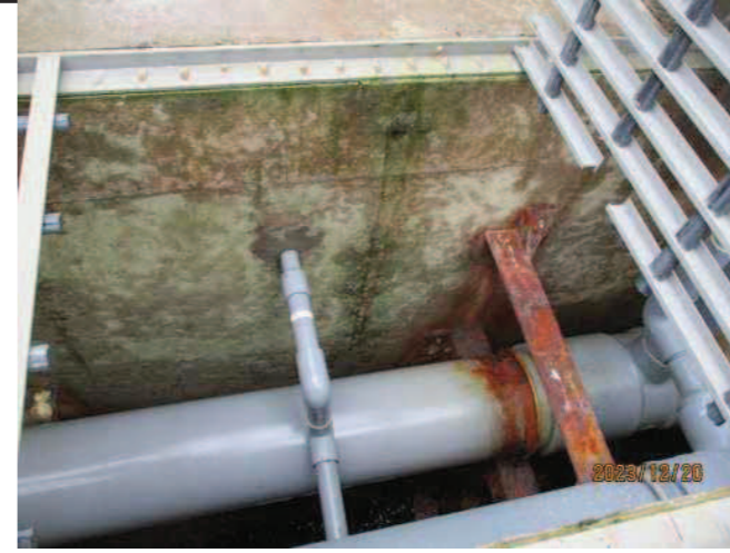
No-3 IMG4868 ビット内 壁、底クラック無し
