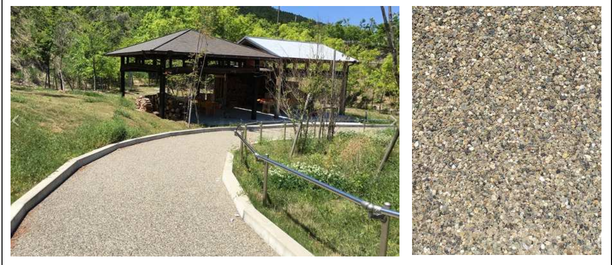
写真 7.1 脱色アスファルト舗装(自然石系)
