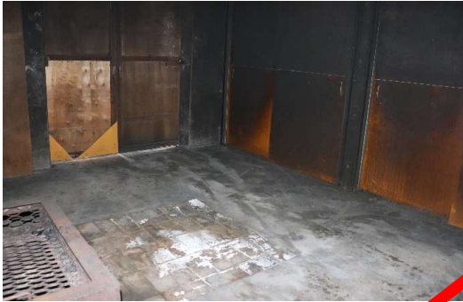
1 階南東燃焼室
