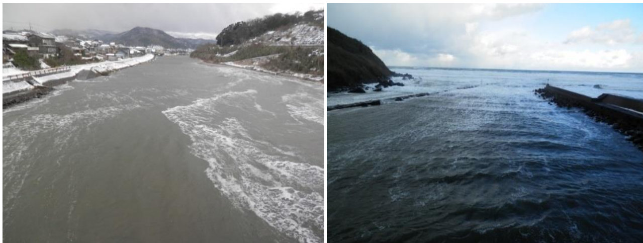
参考写真 勝部川河口における実績の波浪うちあげ状況 H26(2014).12.18 時刻不明
