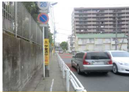
ガードレールの設置
