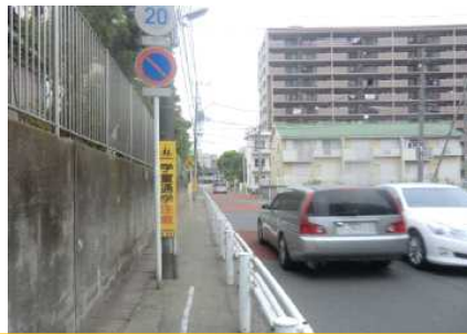
ガードレールの設置
