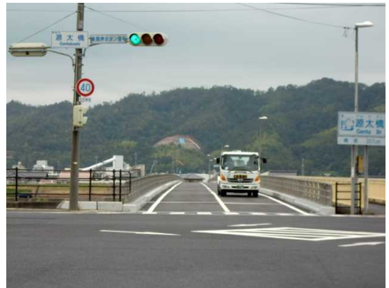
【現況説明写真】② (供用後の状況(右岸側))
