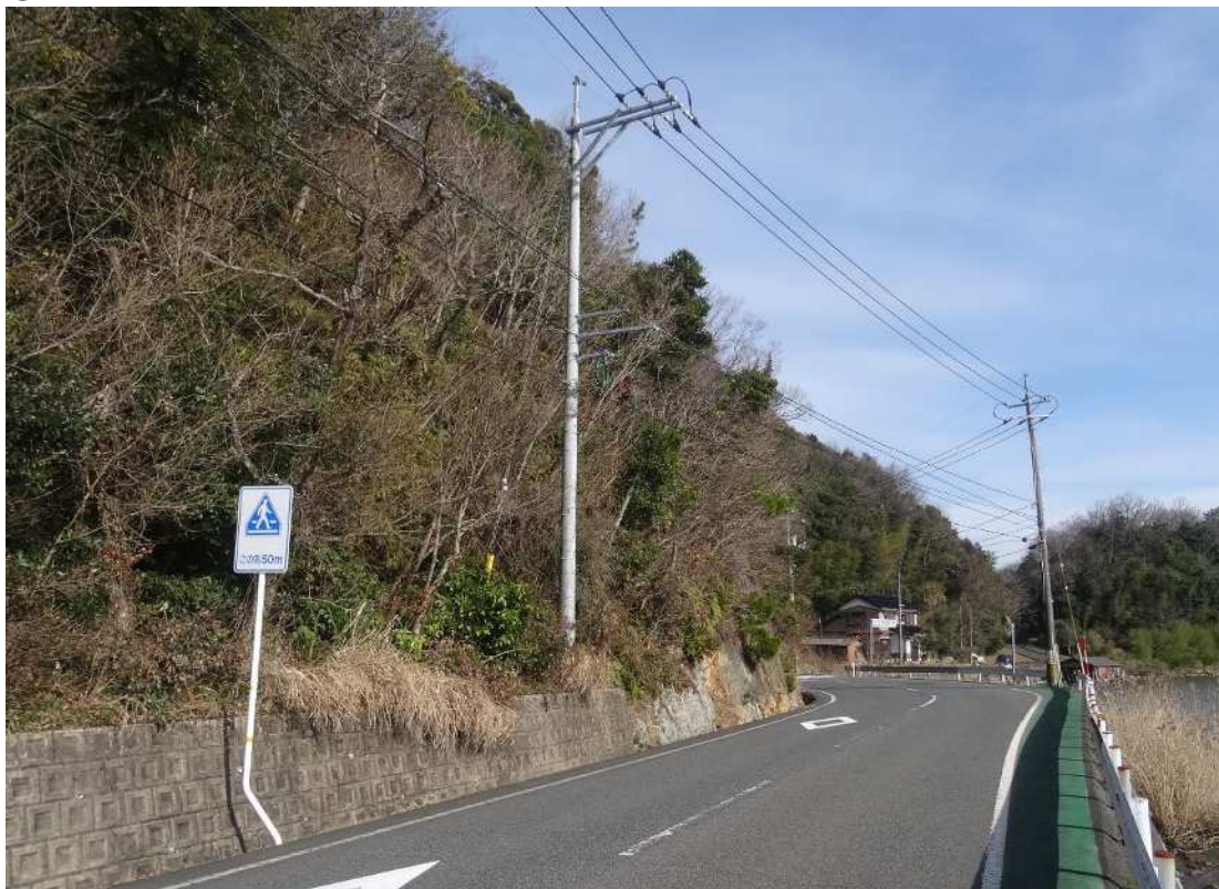
① NO. 7 付近より終点側の現況眺望（起点側から終点側を望む）
