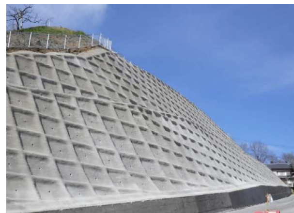
設計変更；枠内モルタル吹付
