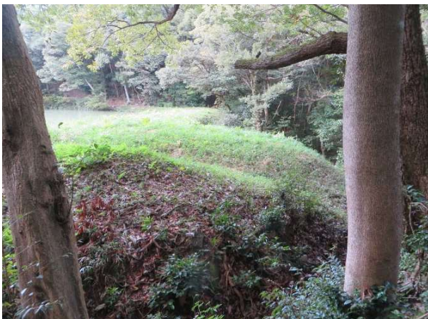
②現況写真（下流側）
