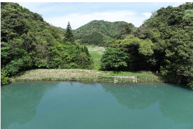
③現況写真（遠景）
