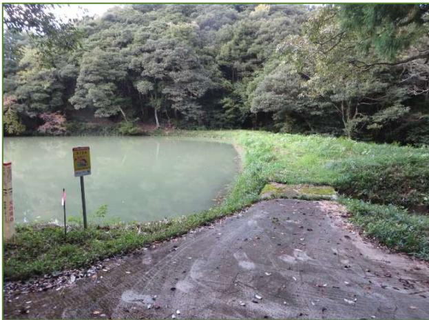
①現況写真（上流側）
