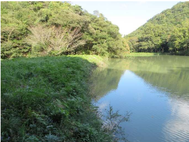
①現況写真（上流側）
