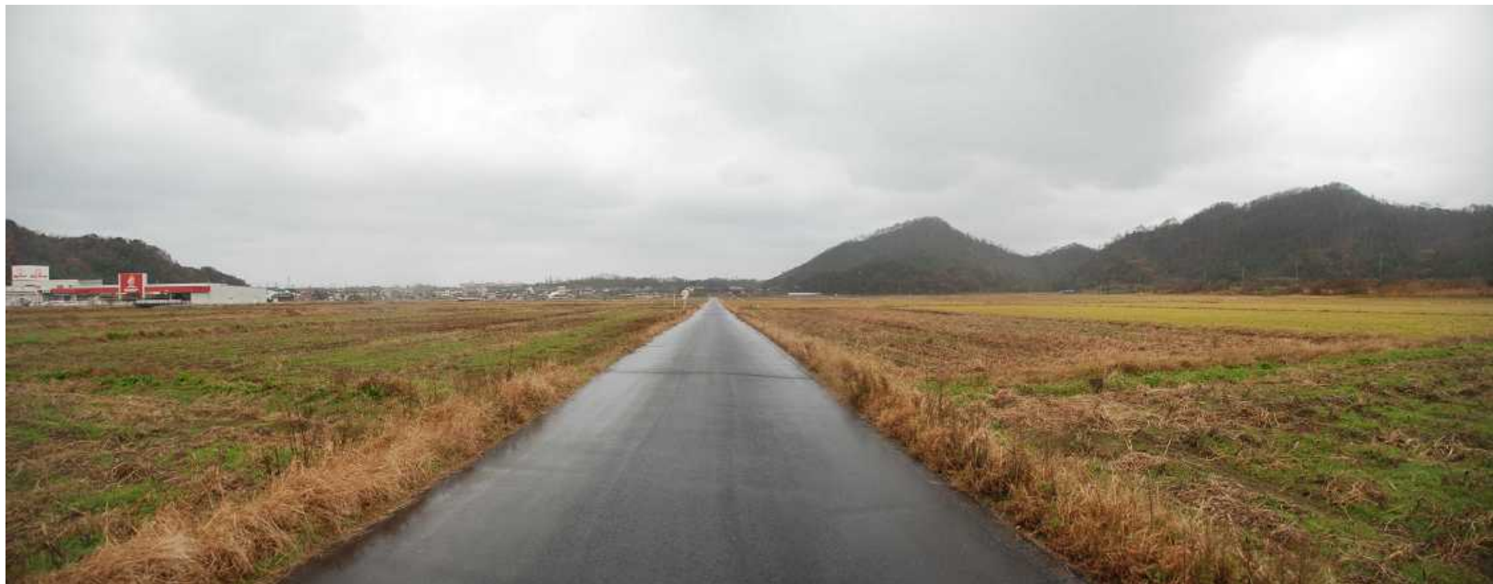
3号橋（仮称）：現況写真
