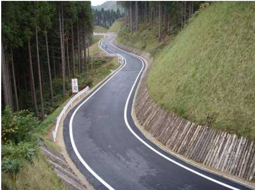
施工時期 平成20年度
