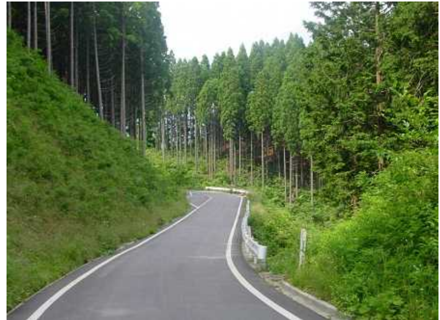
施工時期 平成11年度
