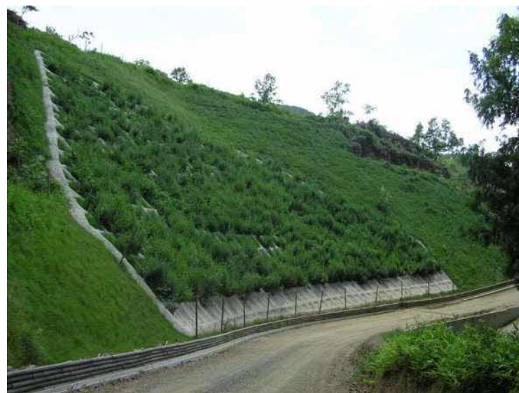
簡易吹付法砕工完成イメージ（施工後 7 カ月）
