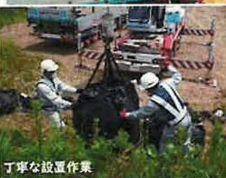
丁寧な設置作業
