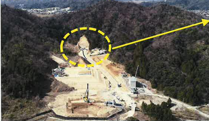
【令和3年3月12日撮影ドローン写真】
