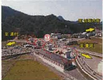
柿谷地区では、高架橋の橋脚4基(①)が完成しました。新温泉浜坂ICで降りるときには、迫力ある橋脚の姿を見る事ができます。これからは、農道が浜坂道路の下をくぐれるようにするためのBOXカルバートの施工や鳥取側へ延伸するための切土工事に着手します。
