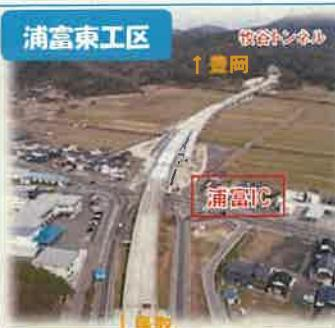
浦富IC周辺では、浦富高架橋の床版コンクリートの施工が進み、橋が繋がるとともにインターチェンジの完成形が見えできました。
