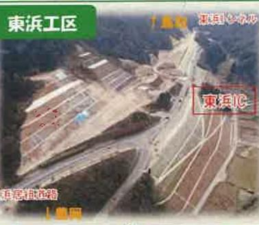
東浜工区では、残っていた大規模な山切工事が完了し、岩美道路全体の形が現れてきました！引き続き、山切できた長大斜面を保護するための法面工事が本格的に始まります。
