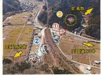
昨年から工事をしていた4基の諸寄高架橋橋脚のうち1基(①)が完成しました。残る3基の橋脚(②)は今年の夏までに完成予定です。釜屋側の山切り工事(③)も順調に進んでいます。また、春からは浜坂側へ繋がるトンネル工事のために、鋼材を組立てて工事用スロープの設置を行う予定です。
