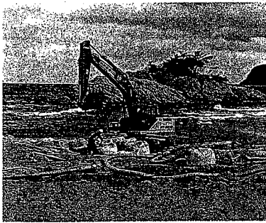
浦富海岸での「鳥取方式のサンドリサイクル工法」試験施工の様子。検証後の更なる展開に期待。
