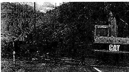
▲平成30年9月台風被害(高城)
