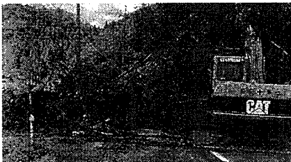
▲平成30年9月台風被害(高城)
