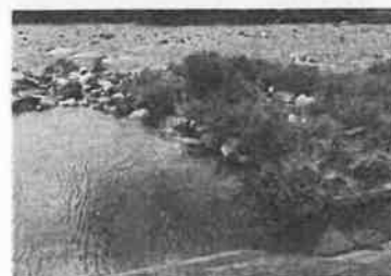
用水路へ水を 入れるための誘導堰
