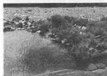
用水路へ水を 入れるための誘導堰
