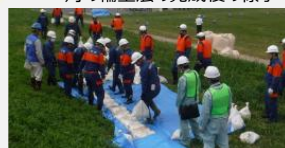
▲改良積み土のう工法の様子
