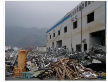
荷捌所の被災イメージ
