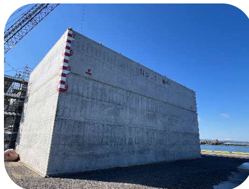
航路切替に向けて製作中のケーソン (第2防波堤延伸工事)
