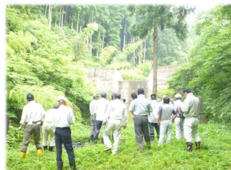
土砂災害防止施設があれば併せてその健全度を点検
