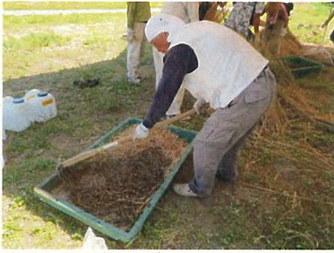
1. あらかじめ、窯を覆うための土をこねておきます。(切りワラを混ぜる。)
