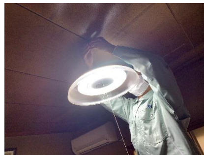
< 電気器具の点検 >
