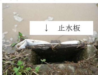
止水板の設置
