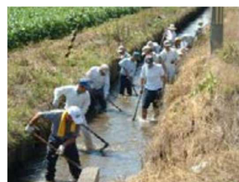
農業用水路の泥上げ
