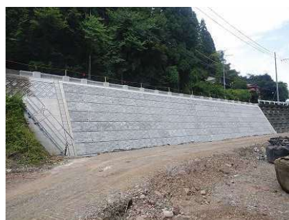
国道482号森坪地内復旧状況
