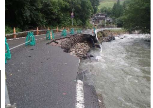
護岸崩壊による通行規制 (H30年7月)
