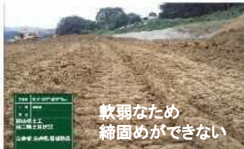
土質改良が必要な他工事発生土
