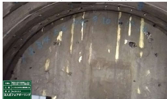
小口径先受け・鏡ボルト 施工完了
