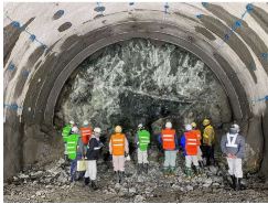
岩質判定委員会による掘削面の確認状況
