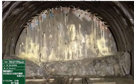
小口径先受け・鏡ボルト 施工完了
