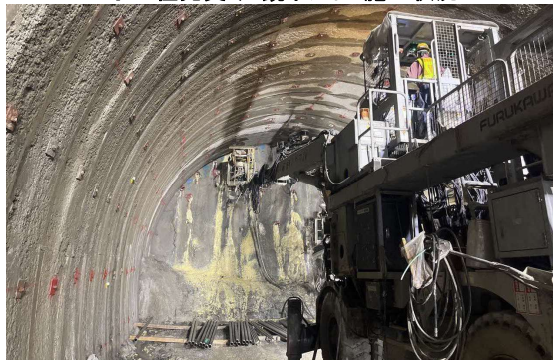
小口径先受け・鏡ボルト 施工状況
