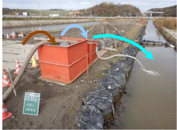
ノッチタンクによる濁水処理
