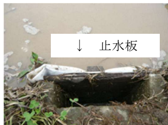
止水板の設置
