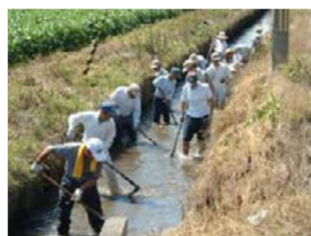
農業用排水路の泥上げ
