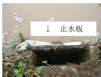
止水板の設置
