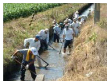
農業用水路の泥上げ
