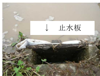
止水板の設置
