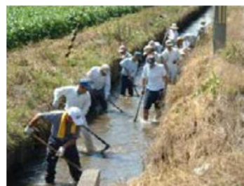
農業用水路の泥上げ
