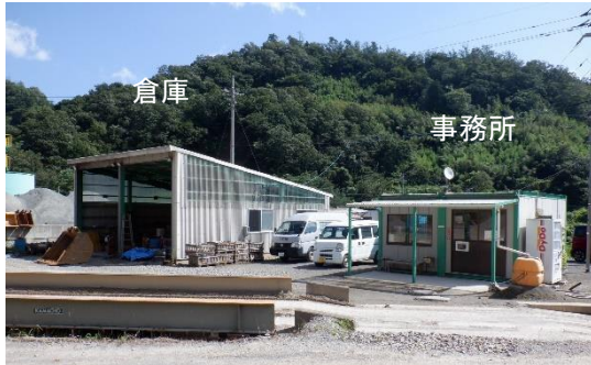
②事務所、倉庫
