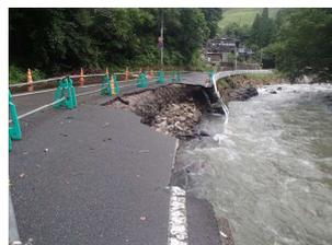
護岸崩壊による通行規制（H30年7月）
