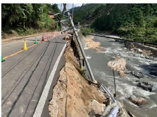
護岸崩壊による通行規制（R5年8月）
