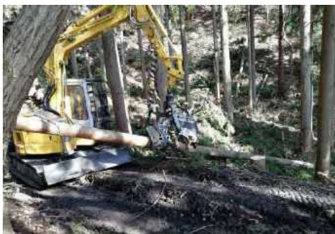
高性能林業機械による施業状況
