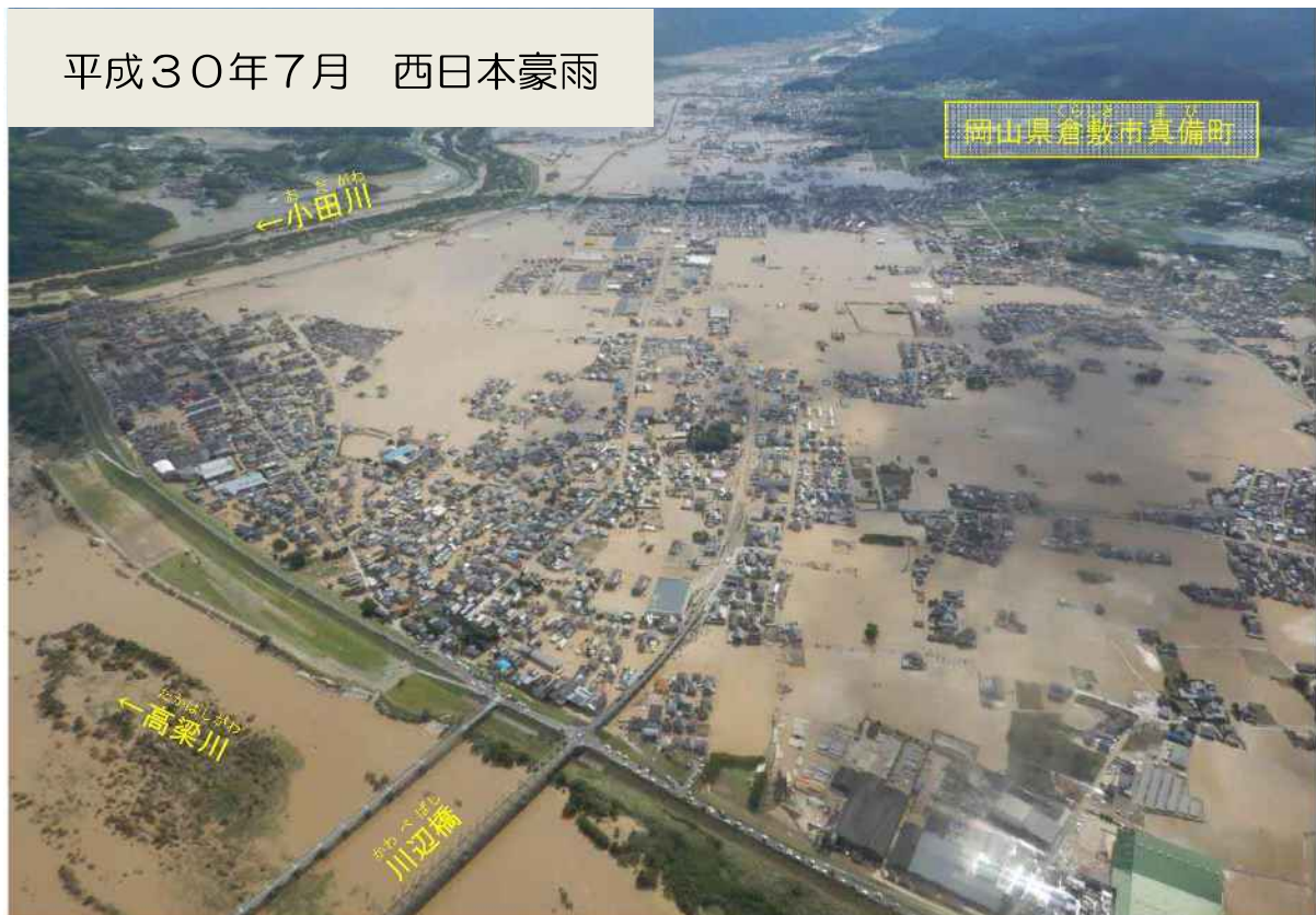
高梁川水系高梁川：岡山県倉敷市真備町（平成30年7月8日(日)：国土交通省撮影）
